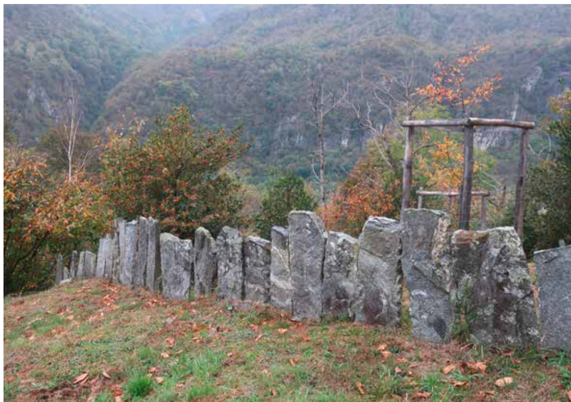
Piode in posizione verticale a Pianasc sopra la frazione di Lüdint: qui, nell'ambito del progetto «Paesaggio Avegno», le superfici agricole sono state di nuovo rese utilizzabili grazie alla rimozione dei cespugli e sono stati piantumati alberi da frutto. Nel quadro del prossimo progetto verranno sistemati i muri a secco.
